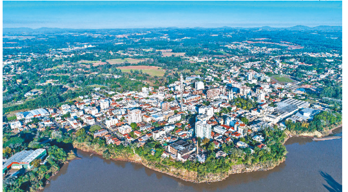
Iniciativa no Vale do Taquari tem como escoar o acúmulo de água com menor intensidade, evitando erosões e cheias na cidade
