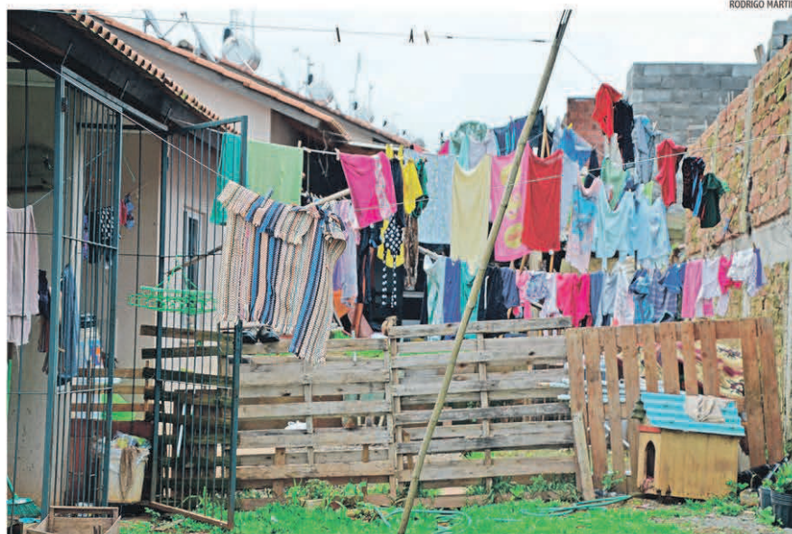
Invasões e construções irregulares são problemas no empreendimento de R$ 23 milhões do Minha Casa Minha Vida
