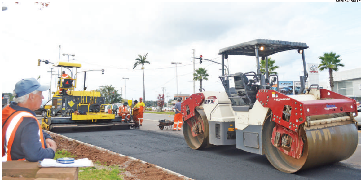
O recapeamento asfáltico das vias laterais foi feito nessa sexta-feira pela empresa MPX, contratada pela EGR
