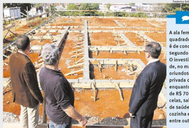
OBRA: Vieira (E) e Johnson (D) visitaram obra coordenada por Katz (C) na tarde de terça-feira
