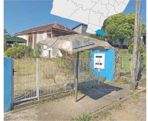
DESCONFORTO: maioria dos abrigos não possui bancos
