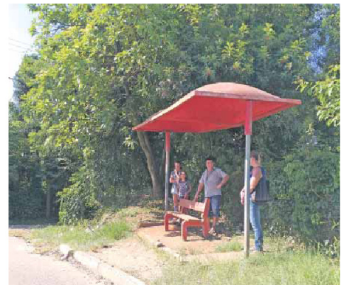
SEM SAÍDA: paradas não protegem os passageiros do sol
