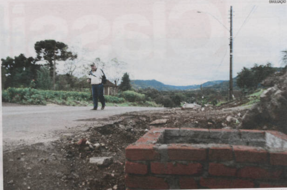
Demora na obra dificulta trânsito de pedestres, saída de carros das garagens e entrada dos moradores nas residências
