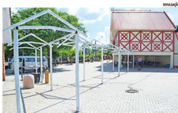
Colocação de toldos entre os prédios era antiga reivindicação dos pais
