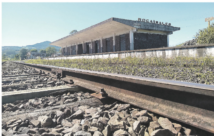
ROCA SALES: estação faz parte de entroncamento ferroviário no Vale do Taquari
