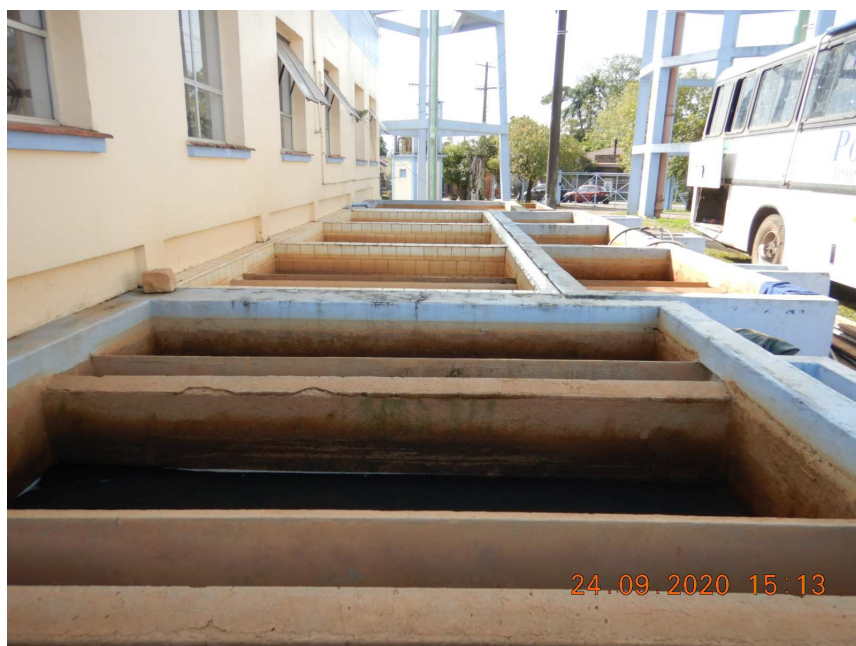
Figura 29: Filtros do tipo fluxo descendente
