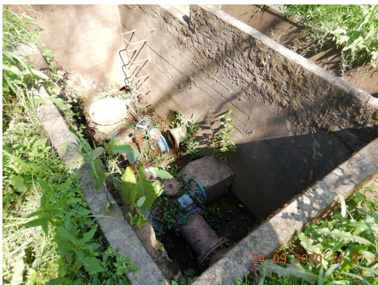
Figura 6: Ponto de saída do recalque "velho"
