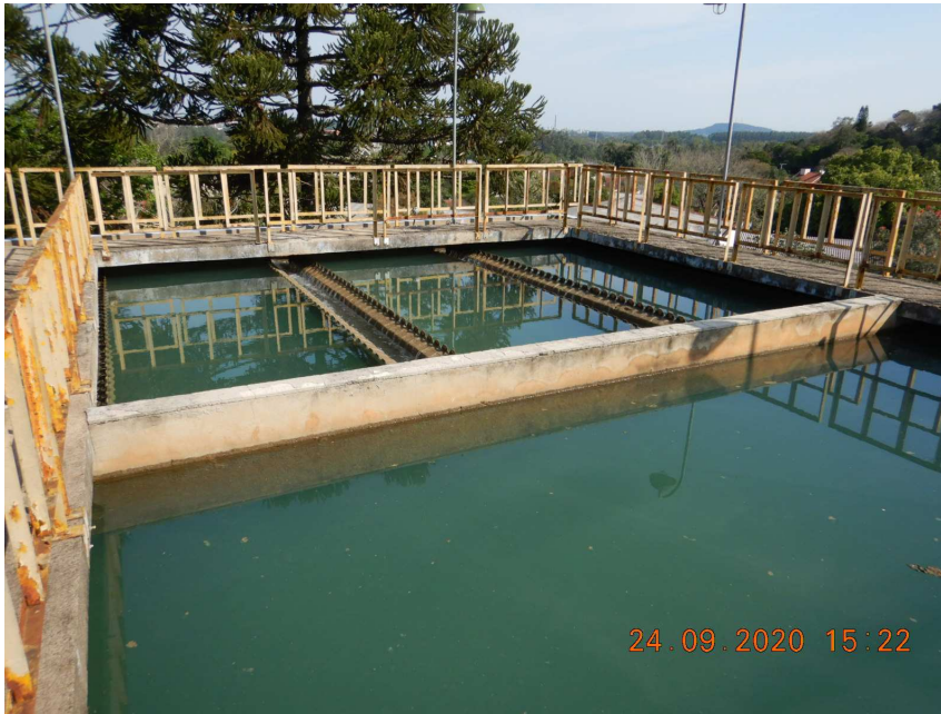
Figura 33: Câmara final de decantação
