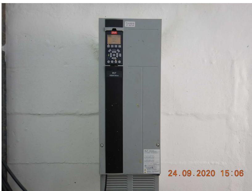
Figura 40: Acionamento do CMB da EAT 02
