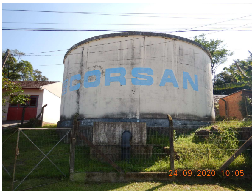
Figura 70: Reservatórios Montanha (Reservatórios R15A e R15B)
