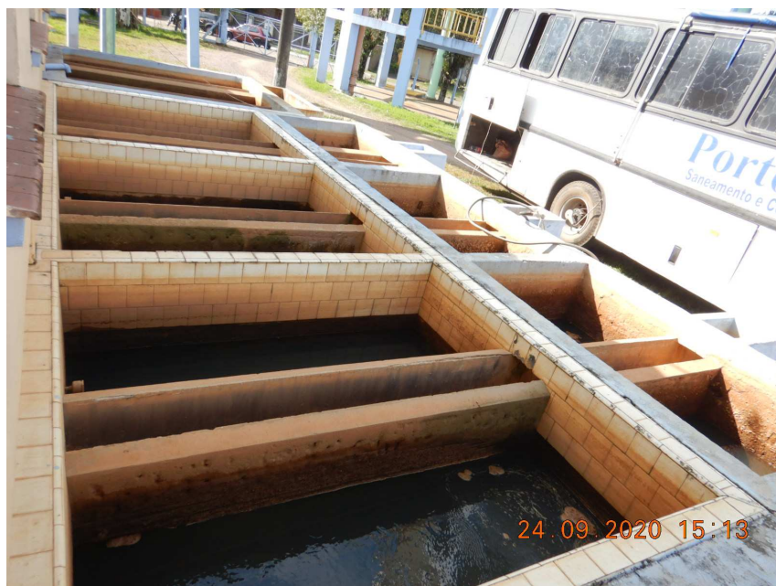
Figura 28: Filtros do tipo fluxo descendente
