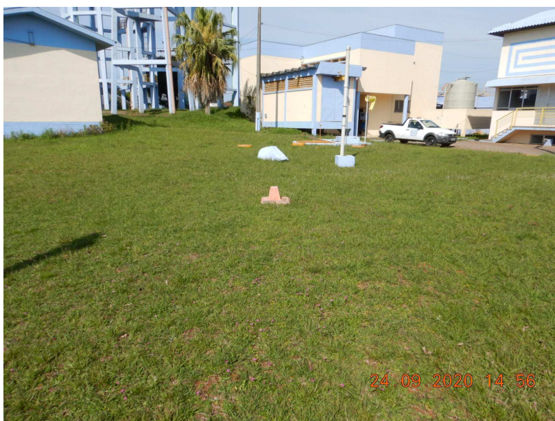
Figura 60: Área dos reservatórios enterrados do Centro de Reservação da ETA (Reservatórios R1 e R2)
