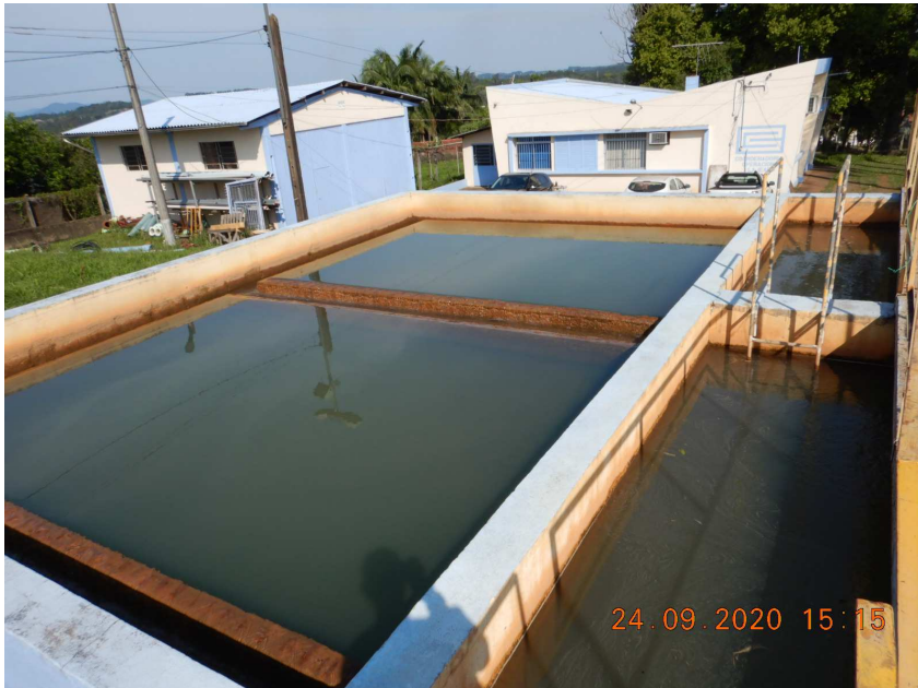
Figura 24: Células de decantação simples
