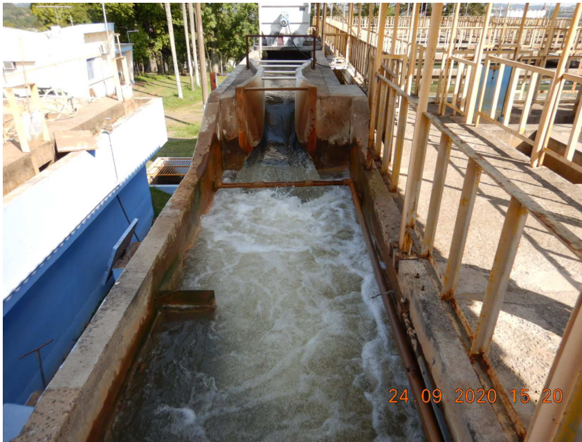
Figura 17: Calha Parshall
