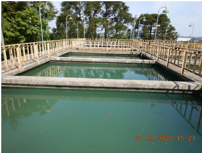
Figura 31: Células de decantação simples
