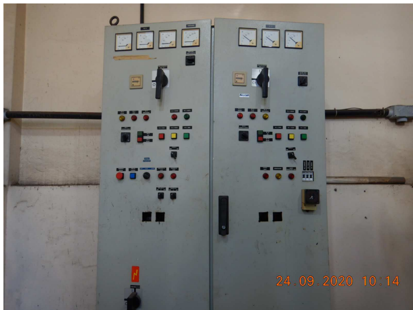
Figura 53: Acionamento do CMB da EAT 09
