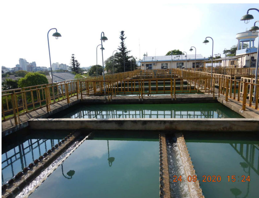
Figura 32: Células de decantação simples
