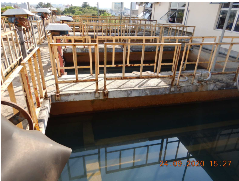
Figura 34: Filtração da ETA Nova
