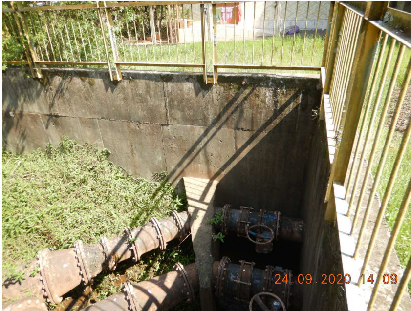
Figura 7: Ponto de saída do recalque “novo”
