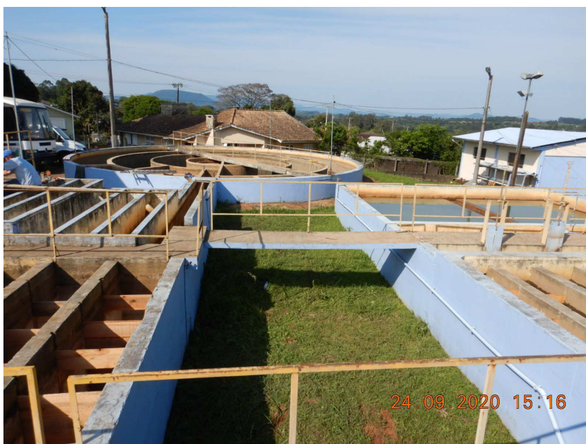
Figura 27: Visão geral do sistema de floculação e decantação
