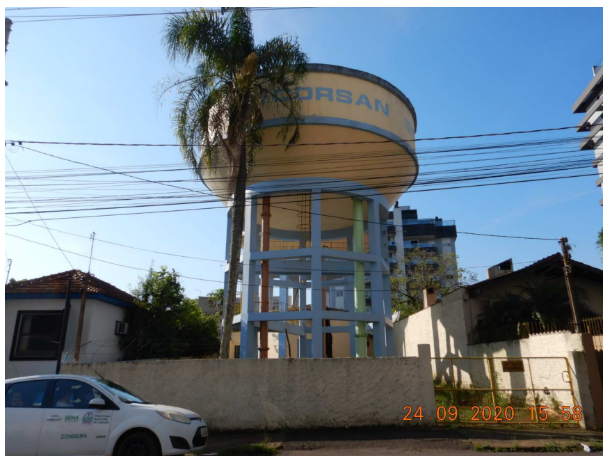
Figura 61: Centro de Reservação Sede (Reservatórios R4A e R4B)
