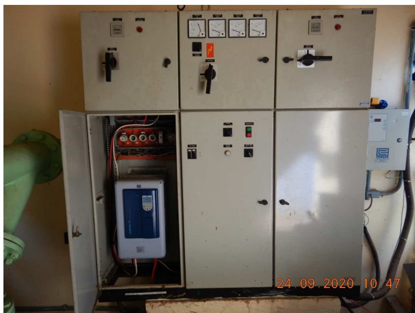
Figura 49: Acionamento do CMB da EAT 06
