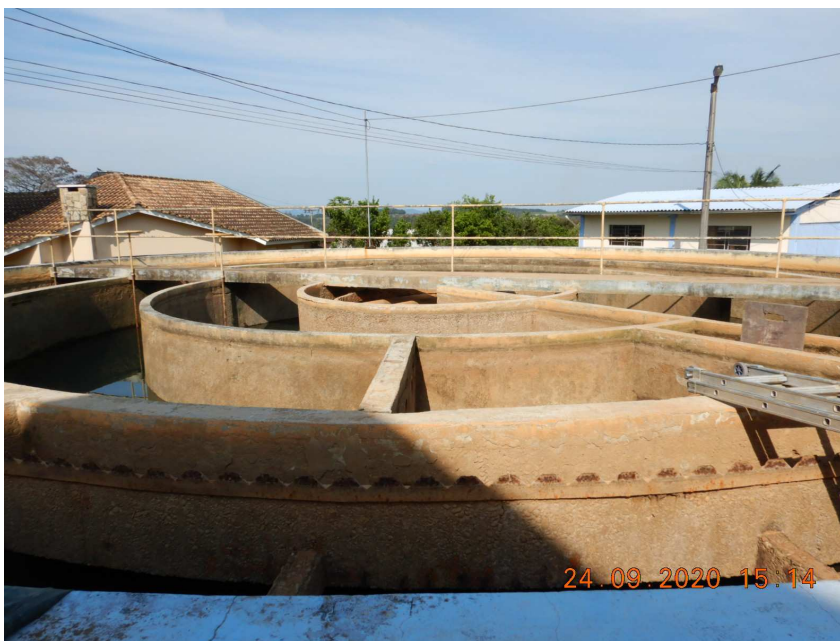
Figura 25: Decantador circular
