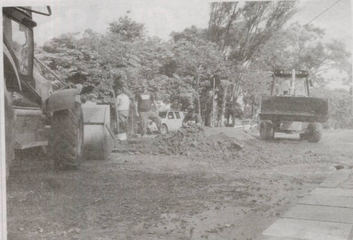
Novo buraco começou a ser feito esta semana na avenida
