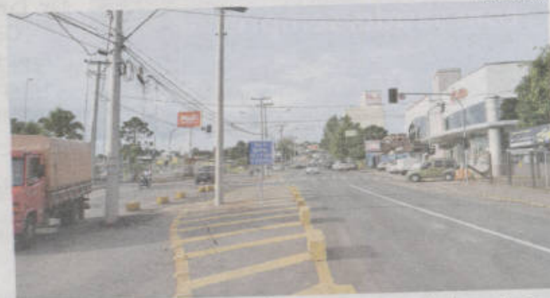
Novo poste, ao lado do antigo, foi instalado ontem. Resta deslocar a fiação
