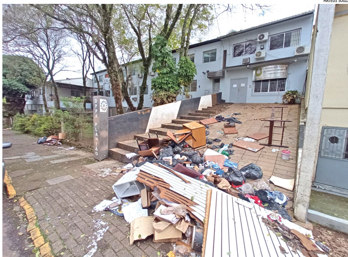
Prédio que sedia quatro delegacias de Lajeado precisa de reformas emergenciais após cheia
