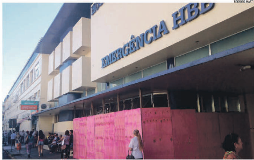
Incêndio no Setor de Emergência pelo SUS interditou a entrada de pacientes. HBB não confirma a reabertura
