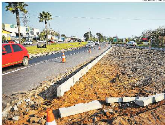
Canteiro central está sendo instalado no km 37 da ERS-130, entre Lajeado e Arroio do Meio
