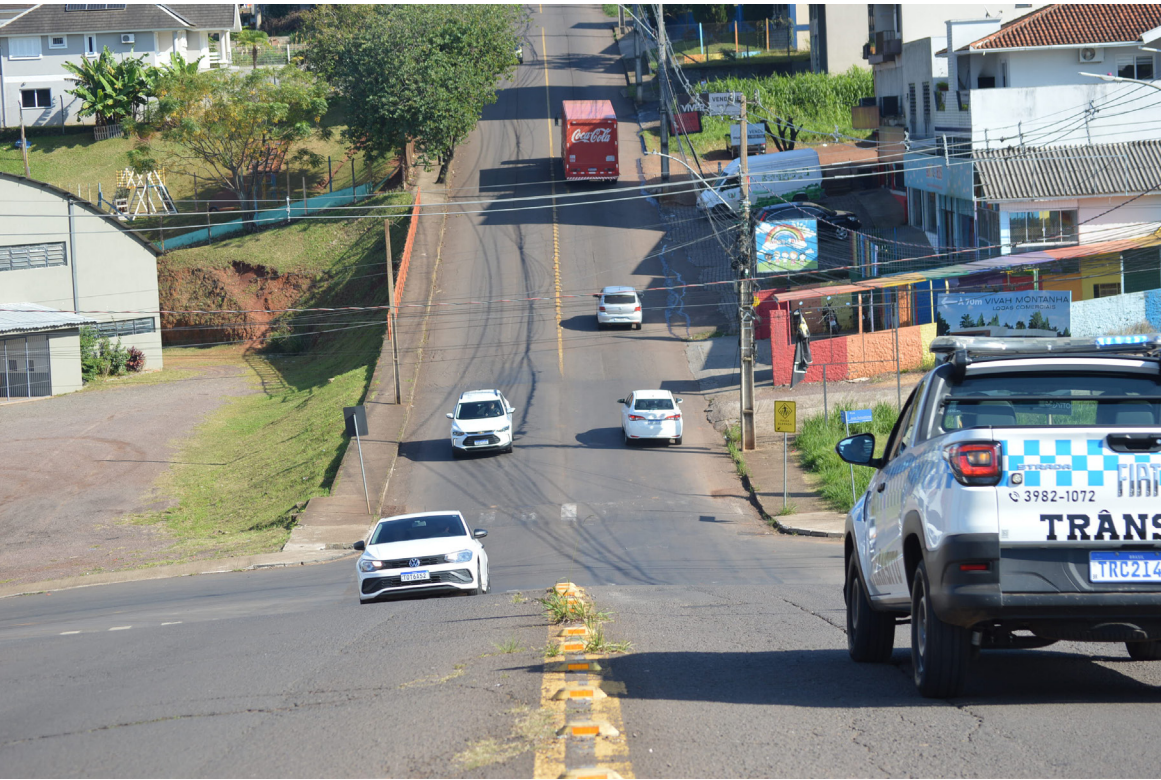
Trecho simples da Av.Benjamin Constant, no Montanha, afunila nos horários de pico e gera congestionamentos
