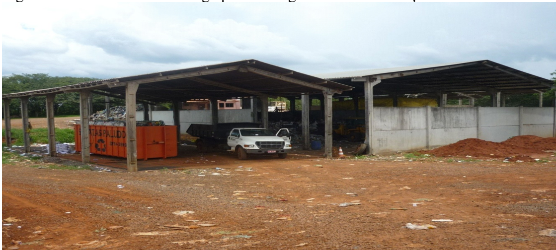
Figura 15: Vista dos fundos do galpão de triagem e caminhão caçamba
