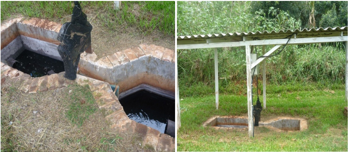
Figura 20: Calha Parshal.
