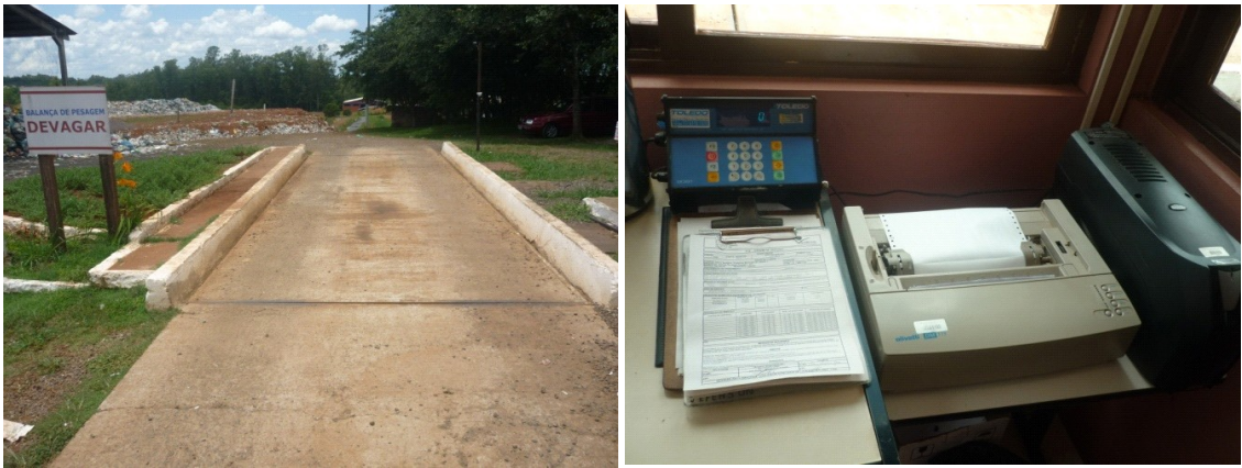
Figura 11: Balança rodoviária e sala de registro das pesagens.
