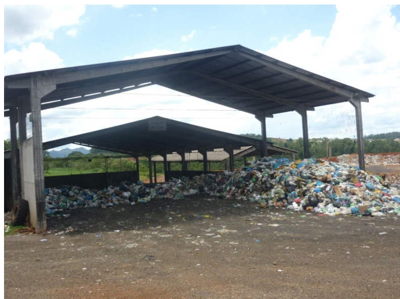
Figura 12: Vista da área de descarregamento dos resíduos sólidos no Galpão de Triagem.
