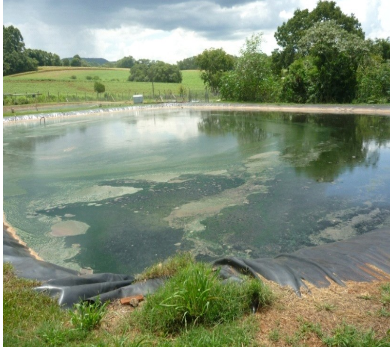
Figura 21: Lagoa Anaeróbica
