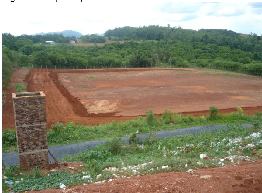
Figura 17: Implantação da Nova Célula do Aterro Sanitário
