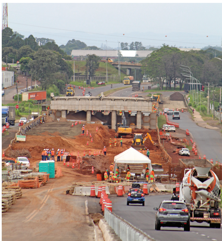
Construção no Montanha teve início em 2022, mas ainda está longe do fim
