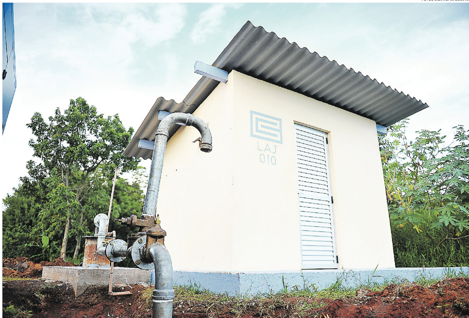
Obra durou em torno de três meses e foi orçada em R$ 500 mil
