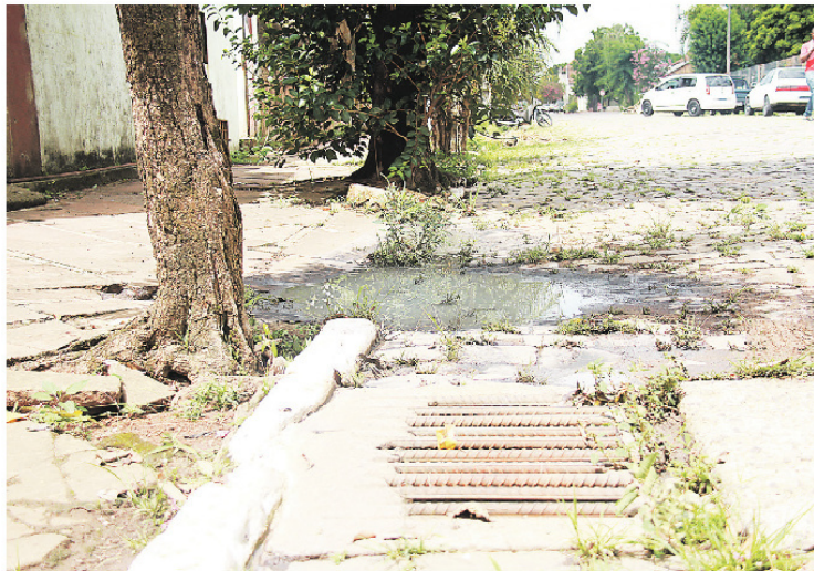
Gordura ficou impregnada em algumas “bocas de lobo” da rua
