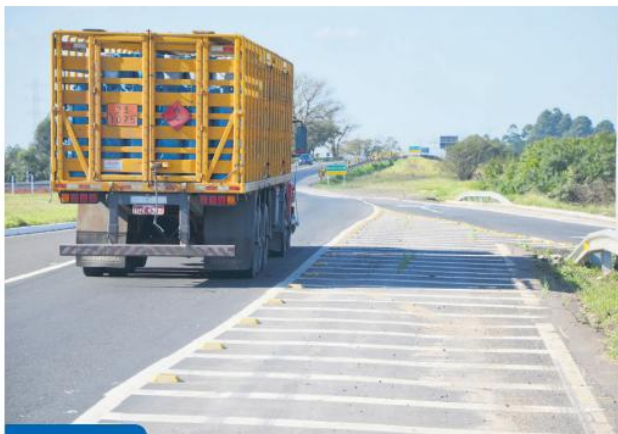
PONTE EM CANOAS estrada em pista simples é um dos gargalos nos quilômetros finais
