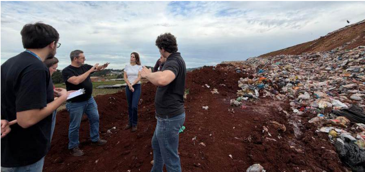
No estudo, será feito um diagnóstico completo da estrutura existente do aterro sanitário
