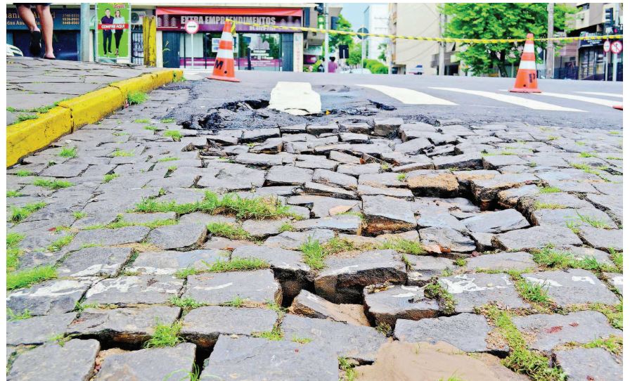
Paralelepípedos afundaram depois de veículo estacionar próximo à esquina da avenida Benjamin Constant
