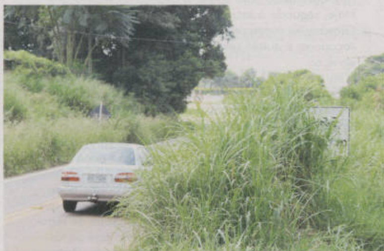
Falta de roçadas também aumenta insegurança nas ERSS, como na ERS-421
