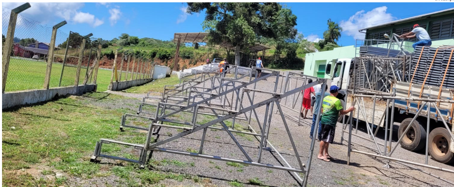
Estrutura de arquibancadas móveis começou a ser instalada na tarde de ontem na sede do 7 de Setembro, em Capitão
