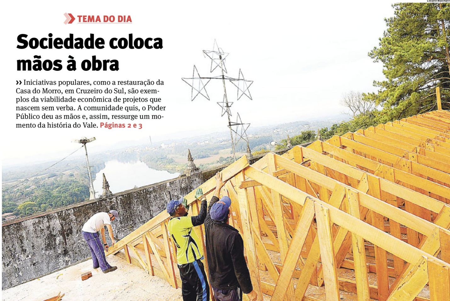
TELHADO: operários dão corpo ao novo telhado em mais uma fase de recuperação do prédio centenário
