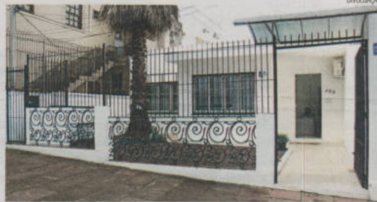
Prédio do Conselho Tutelar fica na rua Francisco Oscar Carnal, 452
