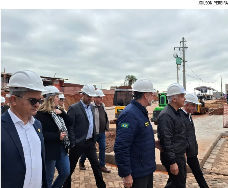
Comitiva do governo federal vistoriou obras e confirmou mais moradias
