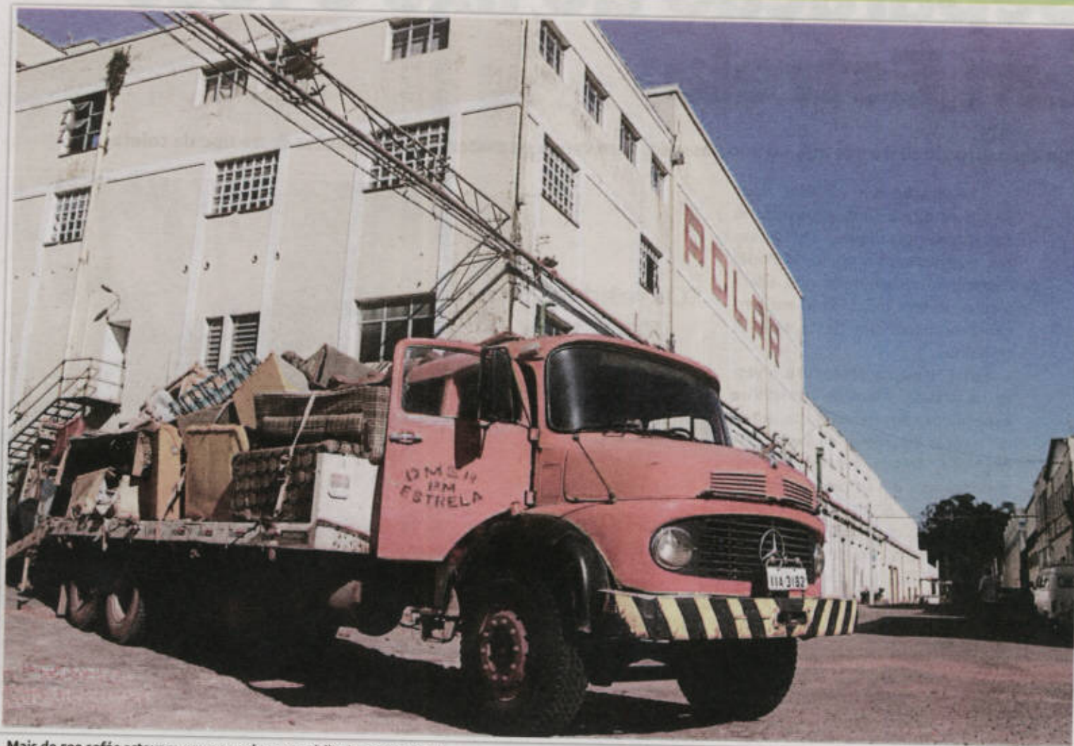
Mais de 500 sofás estavam armazenados em prédio da antiga Polar
