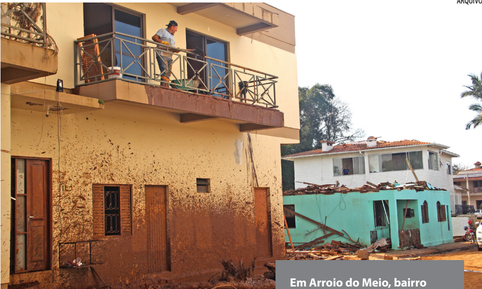
Em Arroio do Meio, bairro Navegantes foi um dos mais atingidos. Dos 4,2 mil pedidos de auxílio, governo federal aprovou 2,5 mil
