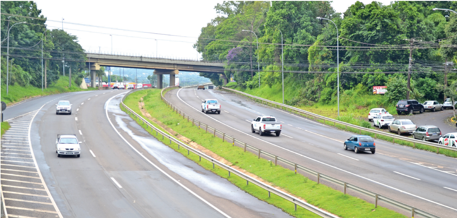
Nova travessia passa sobre a BR-386 e ficaria a poucos metros da ponte existente hoje, na rua 17 de Dezembro. Obra será custeada pelo municípios
