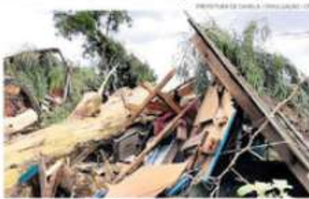
Casas em Canela ficaram totalmente destruídas e outras 70, destelhadas
