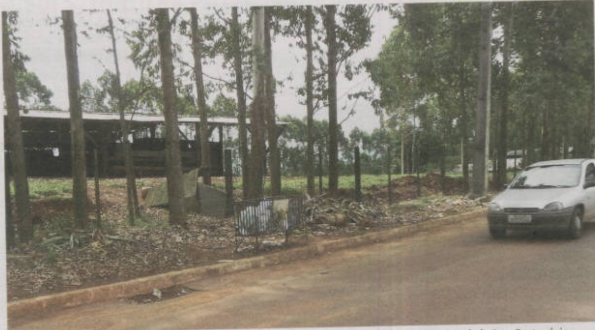
Acúmulo de folhas entope bueiros próximo a terreno. A água teria invadido pátios de casas do bairro Centenário
