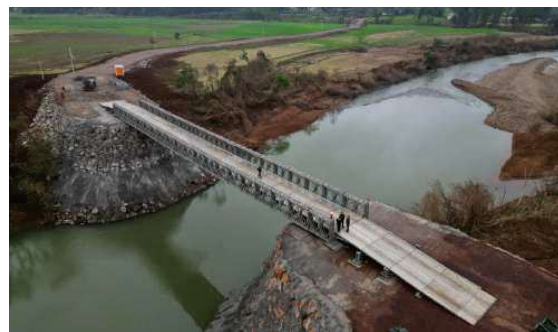
Nova travessia será construída no mesmo ponto onde funcionou a ponte do exército em 2024
