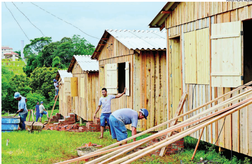
Na tarde de ontem, servidores públicos e operários da empresa contratada finalizavam retoques em seis casas
