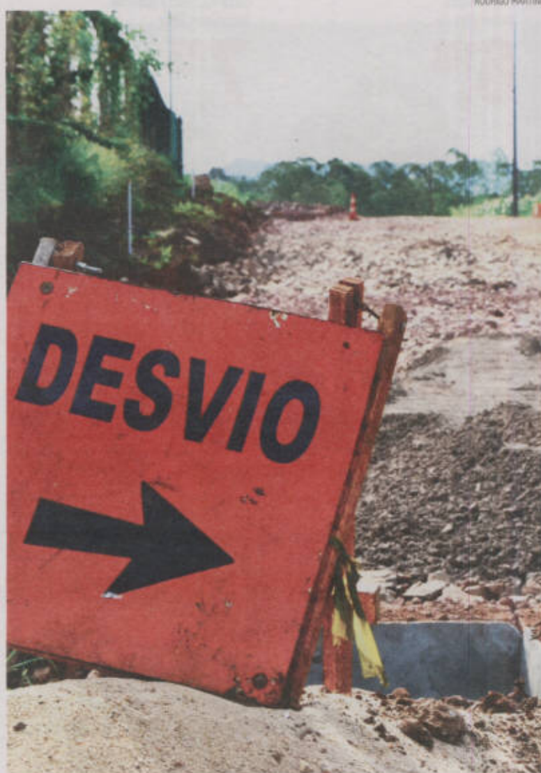
Na rua Pedro Petry, no bairro Carneiros, máquinas não atuaram ontem
