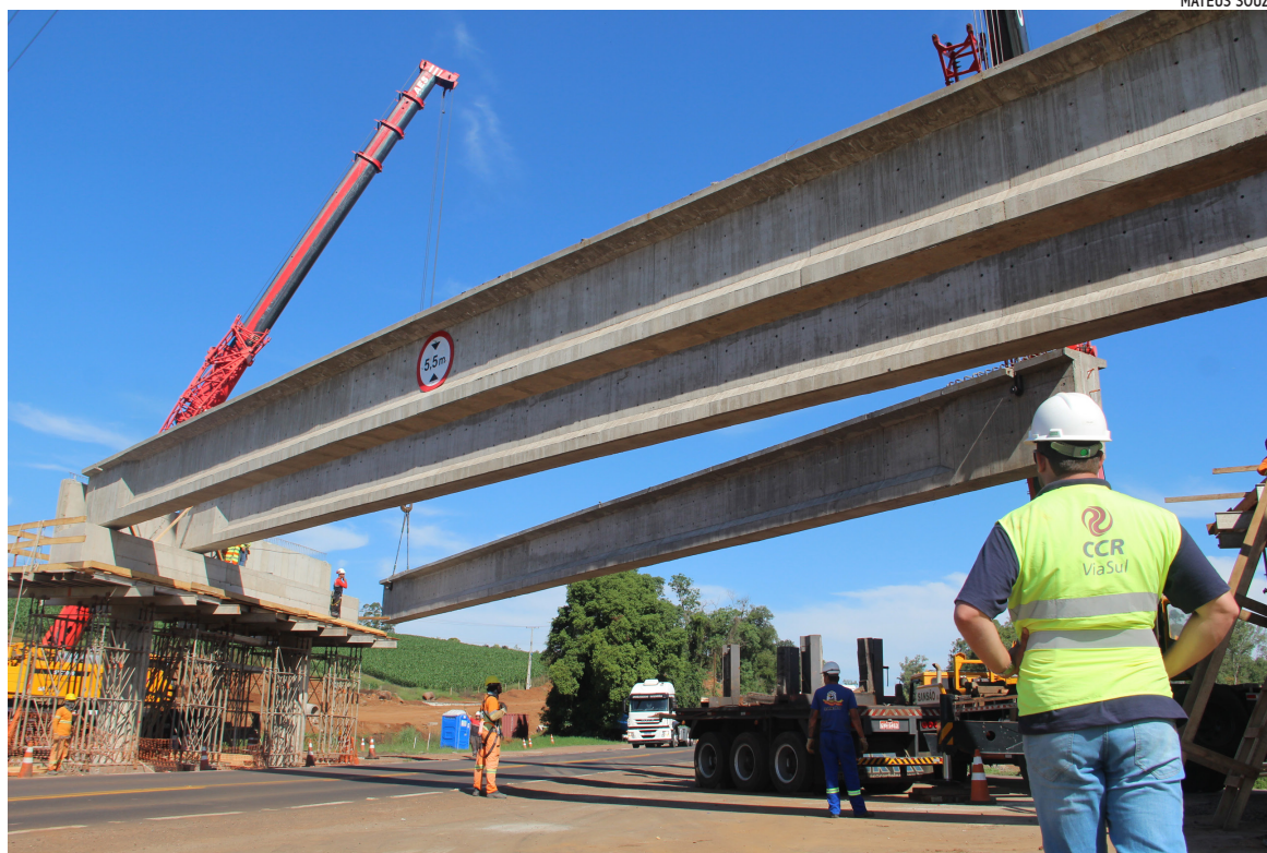
Vigas pesavam cerca de 50 toneladas. Estruturas formam viaduto que ligará os bairros Conventos e Imigrante
