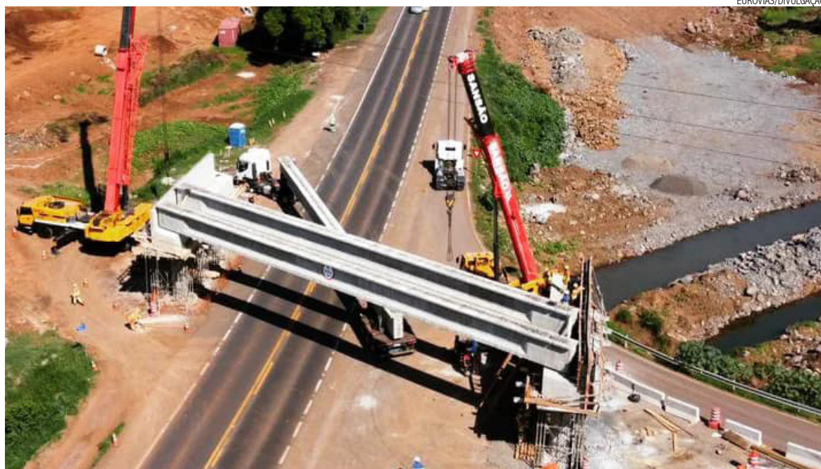
Trecho de Lajeado terá duas passagens inferiores após a conclusão da duplicação
