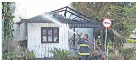
SOMENTE DANOS: chamas consomem casa desabitada
