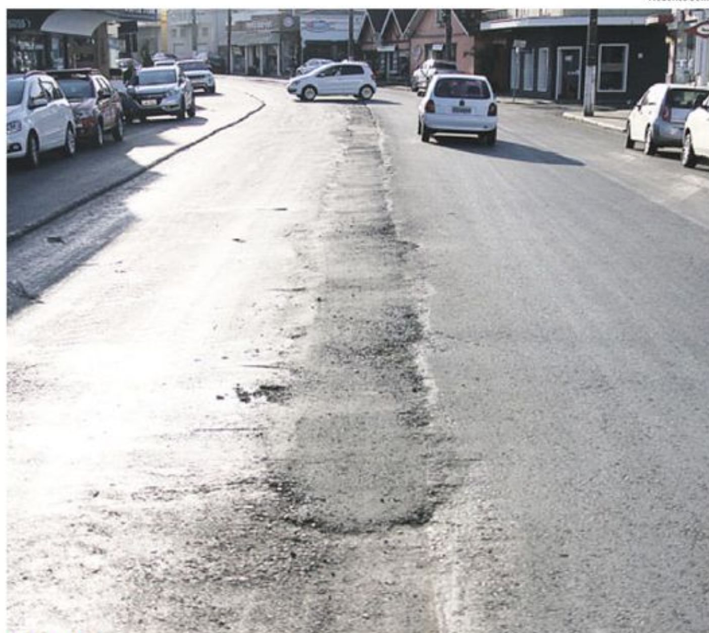
VALETA: retirada dos canteiros será preenchida por camada que finaliza o asfaltamento
