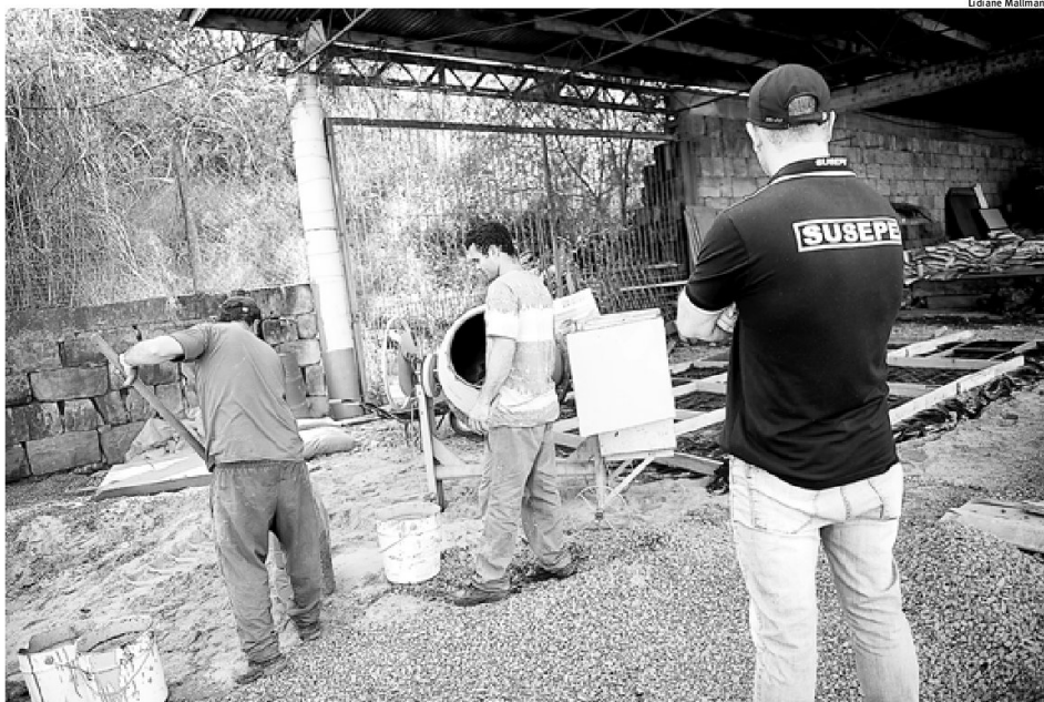
TRABALHO: agente penitenciário supervisiona trabalho de detentos na Secretaria de Obras e Serviços Urbanos de Lajeado
