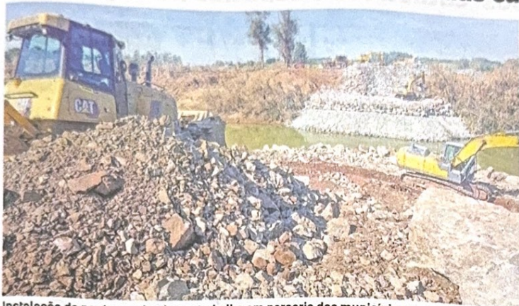
Instalação da ponte resulta de um trabalho em parceria dos municípios, responsáveis pelas obras nas duas margens, iniciadas logo depois da enchente, e do Exército Brasileiro
