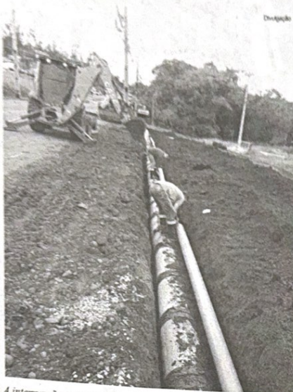
A interrupção ocorre, todos os dias em que houver obra, entre as 8h e as 18h. Após, o abastecimento retorna gradualmente até as residências
