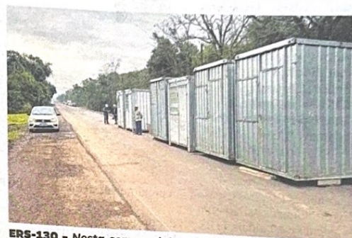
ERS-130 - Nesta semana iniciou a instalação do canteiro de obras para a construção da nova ponte sobre o rio Forqueta, na ERS-130. A previsão da EGR é de que a estrutura seja concluída até dezembro
