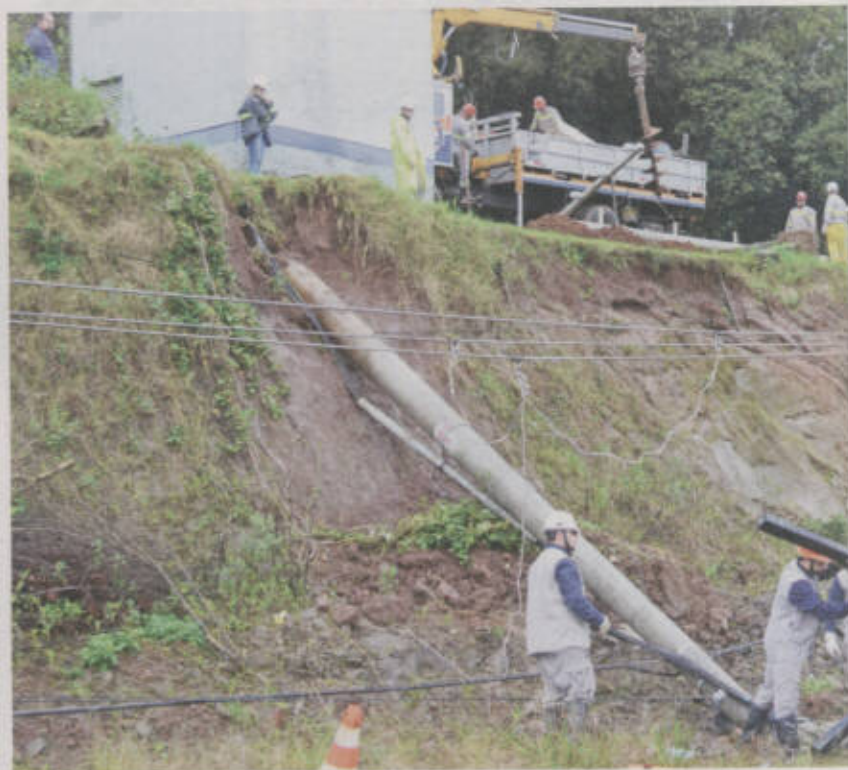
Equipes atenderam diversos chamados para reparos na rede de abastecimento
