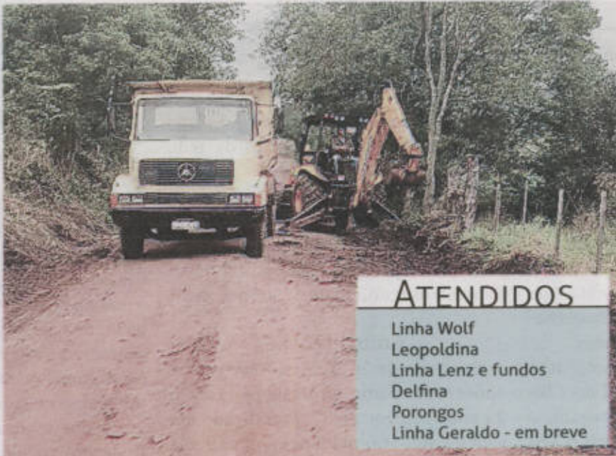
Máquinas limpam valas na localidade de Leopoldina
