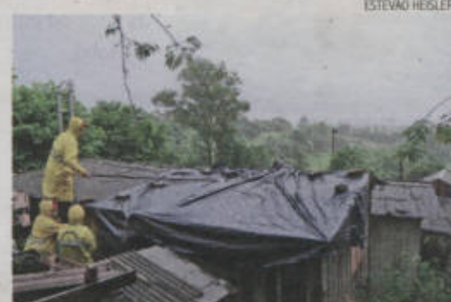
Cerca de cem casas foram destelhadas pelo temporal registrado no domingo
