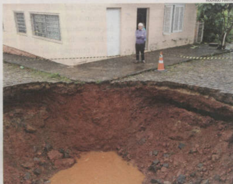
Buraco em rua do São Cristóvão chegou a 20 metros quadrados
