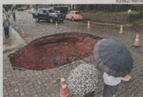
Volume de água abriu cratera com mais de 20m² no bairro São Cristóvão, em Lajeado
