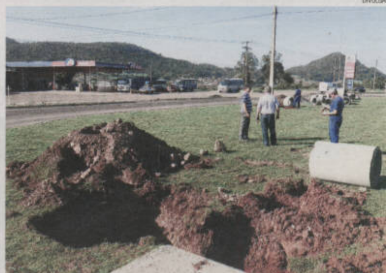
Preparo para colocação dos postes de iluminação iniciou na sexta-feira
