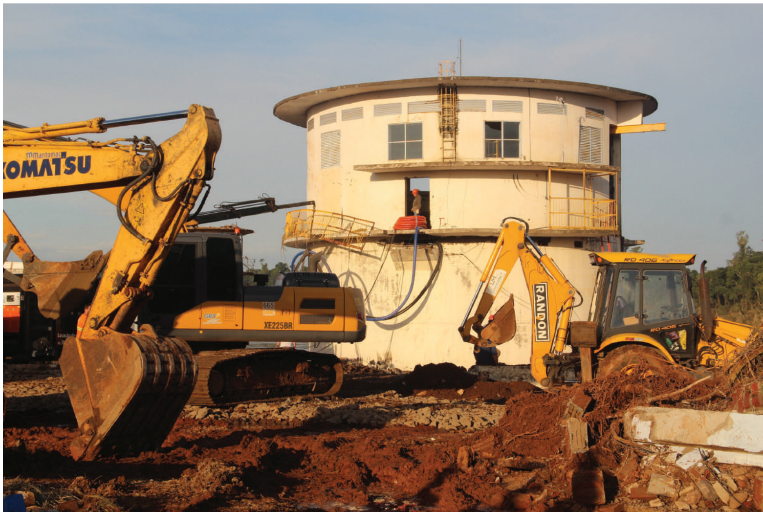
Tubulação entupiu no ponto de sucção e interrompeu o abastecimento para todos os usuários de Lajeado
