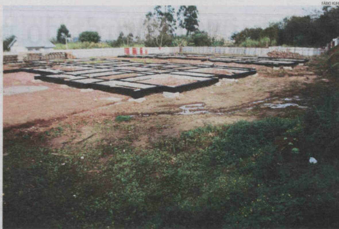
Construção da escola Doce Infância vai abrir 58 novas vagas. Ontem à tarde, nenhum funcionário trabalhava na obra
