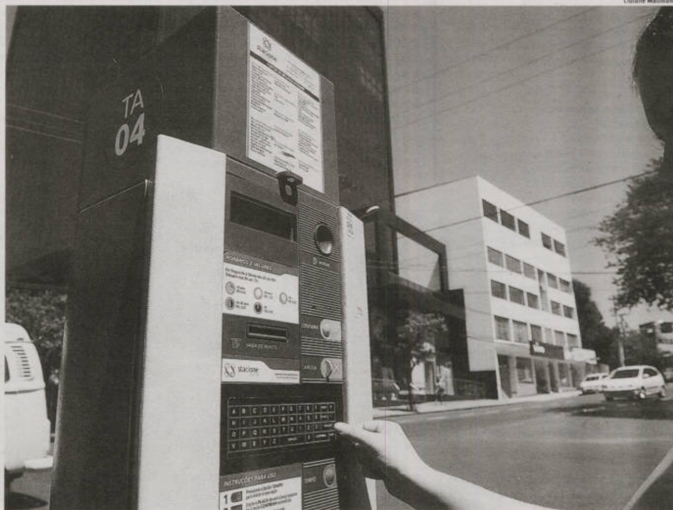
TERMINAIS DE AUTOATENDIMENTO: usuários podem usar equipamentos para pagar estacionamento
