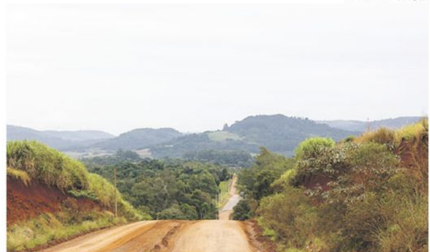
OBRA: pavimentação facilitará o deslocamento do Centro ao bairro e vice-versa
