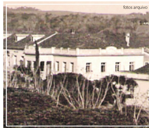
Prédio da família Matte, em que funcionou a primeira Intendência, entre 25 de fevereiro de 1891 e 20 de agosto de 1900. Deu lugar ao hoje Castelinho
