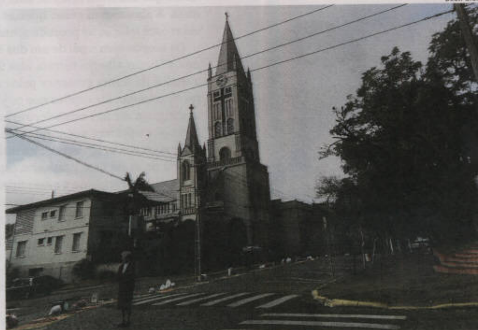
Casa Canônica deverá ser demolida porque atrapalha a vista da igreja
