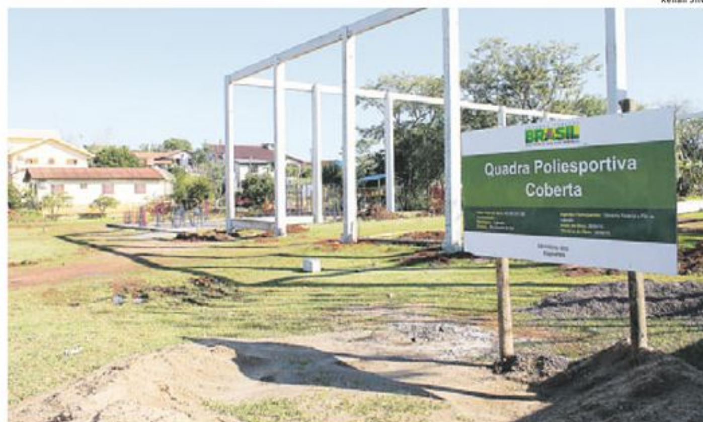
ESPORTES: quadra coberta está em construção junto à academia ao ar livre
