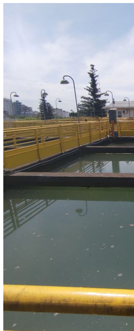
Estação de tratamento de água em operação e assegura qualidade ao consumo, o esgoto não
