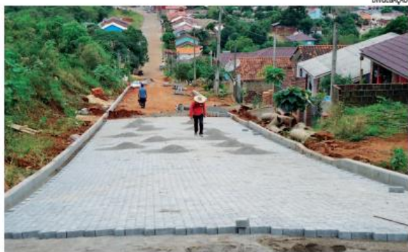
No bairro Glucostark, a rua Silvestre Siebenborn recebeu blocos de concreto
